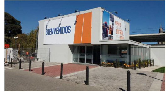
Estación Intermodal Coronel
