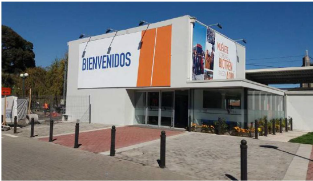
Nueva Estación Intermodal Coronel
