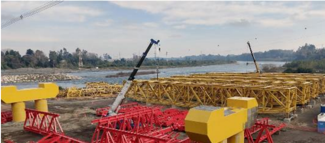
Trabajos de reconstrucción del puente Toltén
