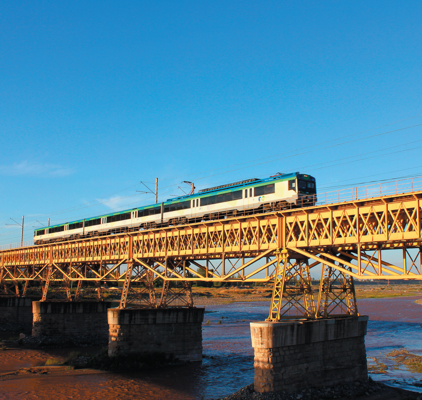
Servicio Metrotren cruzando el puente sobre el río Maipo
