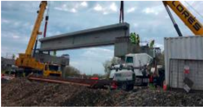
Montaje de vigas del puente Cautín
