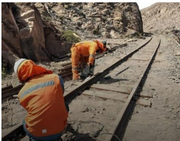
Trabajos en EFE Arica la Paz
