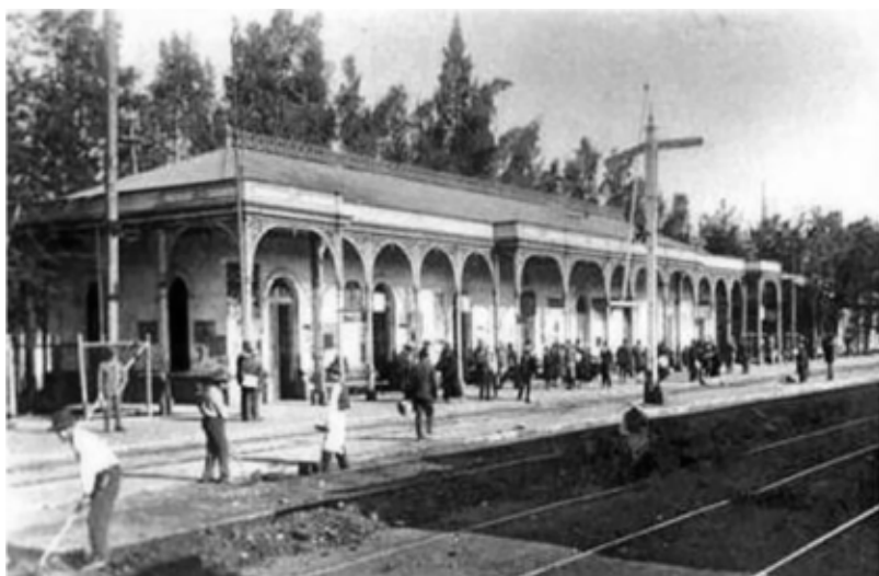
Figura 8: Estación San Bernardo, 1857. (Archivo Fotográfico EFE)
