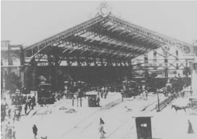
Figura 10: Tercer edificio de la Estación Central, 1900. (Archivo Fotográfico EFE)
