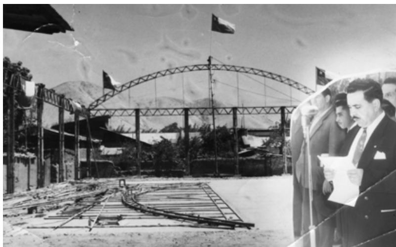
Figura 31: Construcción del Gimnasio Ferroviario de San Bernardo, 1957. (Gentileza de Gabriel Salazar, Colección Raúl Aguilera, Archivo Histórico de San Bernardo)
