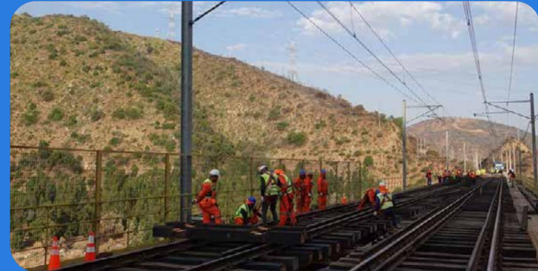
coordinación intersectorial, en tiempo récord el Tren Limache-Puerto pudo reanudar su servicio, tras superar el impacto provocado por el fuego en distintos puntos de la red. El trabajo involucró la reparación de 4 kilómetros de vías afectadas, más de 1.500 durmientes en el **tramo de Las Cucharas y Paso Hondo y terraplenes**, como también la completa normalización de los sistemas de comunicaciones y señalización.
